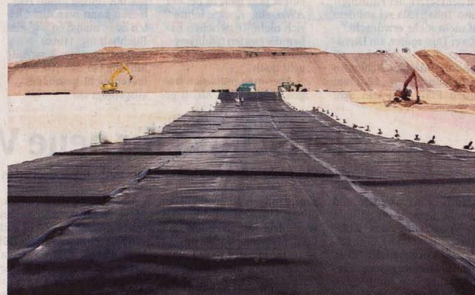
**Die Abdeckung mit Folienbahnen soll verhindern, dass Regenwasser eindringt und Schwermetalle ins Grundwasser ausgewaschen werden.**
